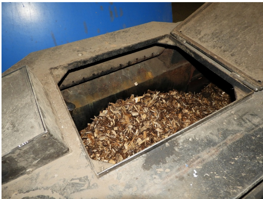
Obr. 1 Palivové štiepky ihličnatých drevín v zásobníku spaľovacieho zariadenia.
