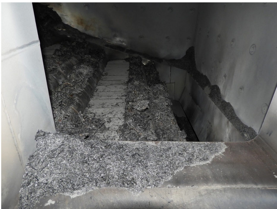
Obr. 2 Najväčšie množstvo popola sa získava zo spaľovacieho priestoru kotlov.
